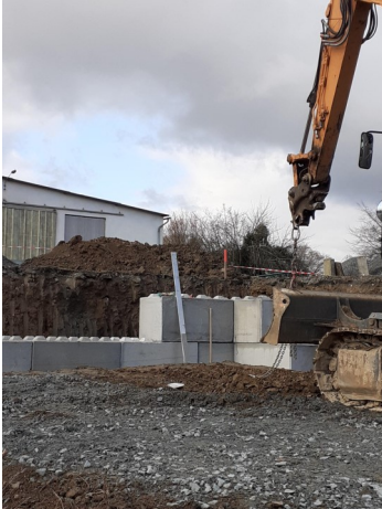
Travaux d'installation du NRO
